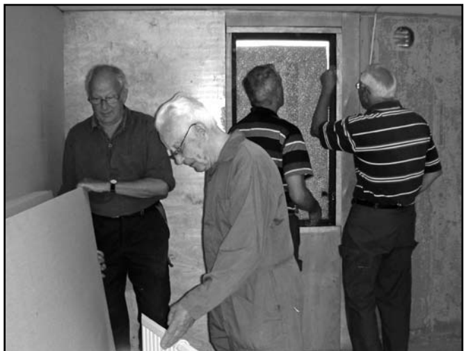
En del av bygggänget i färd med att klä om väggarna och förvandla det gamla förrådet i museibyggnaden till ny utställning. Fr.v. Rolf Nyberg, Alf Eriksson, Hans Edelbrandt och Börje Järving.
