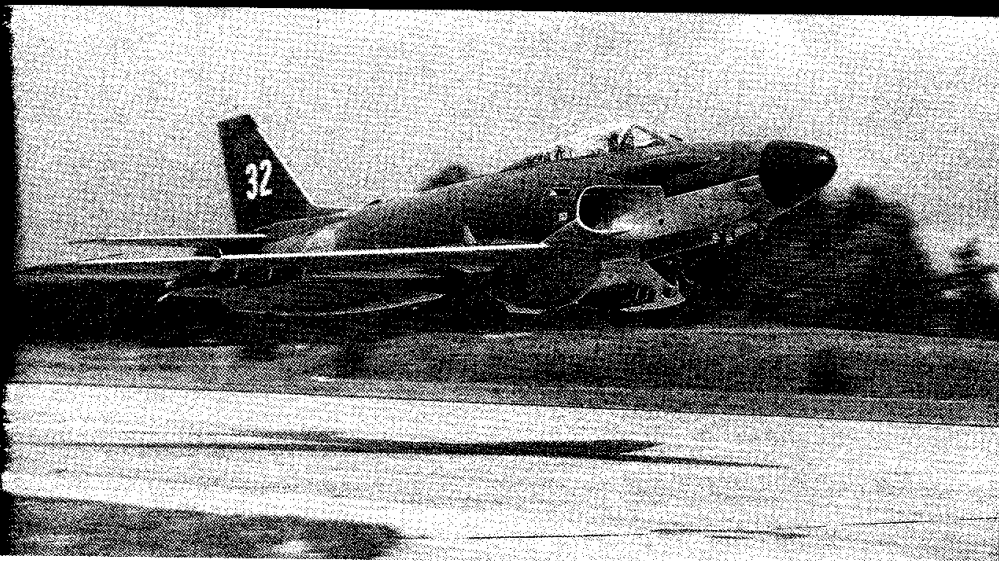
S 32C under start. Landstället har redan fällts in och noshjulet kommer sist. Foto Åke Andersson, SAAB.
